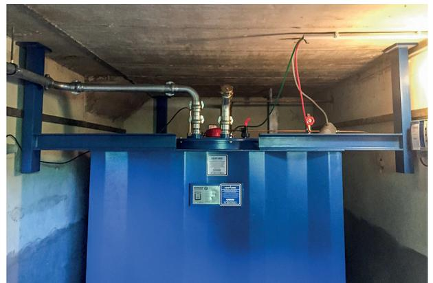
Auftriebssicherung standortgefertigter Stahltank
